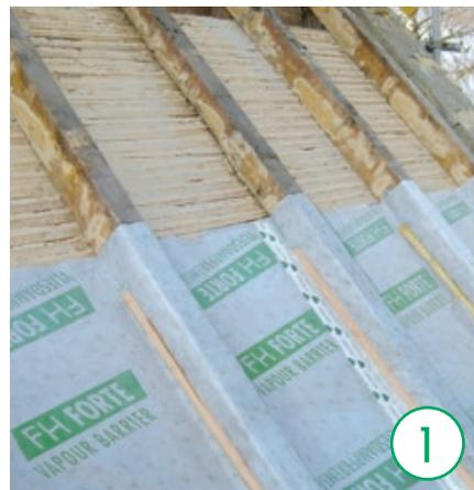
Die alte Dachhaut wird entfernt. Die Dampfbremse (z.B. FH Forte) wird im sogenannten Sub-top-Verfahren über die Sparren verlegt und seitlich mit Latten oder Anpress-Streifen fixiert. Die luftdichte Abdichtung erfolgt mit dem AIRSTOP Klebesystem.
